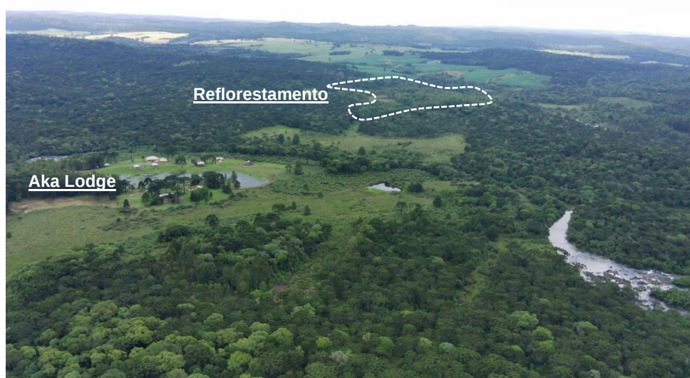
Figura 21: Áreas de reflorestamento, ao fundo, previsto como bota-fora do canal adutor auxiliar e Aka Lodge, empreendimento referência de turismo rural na região.
