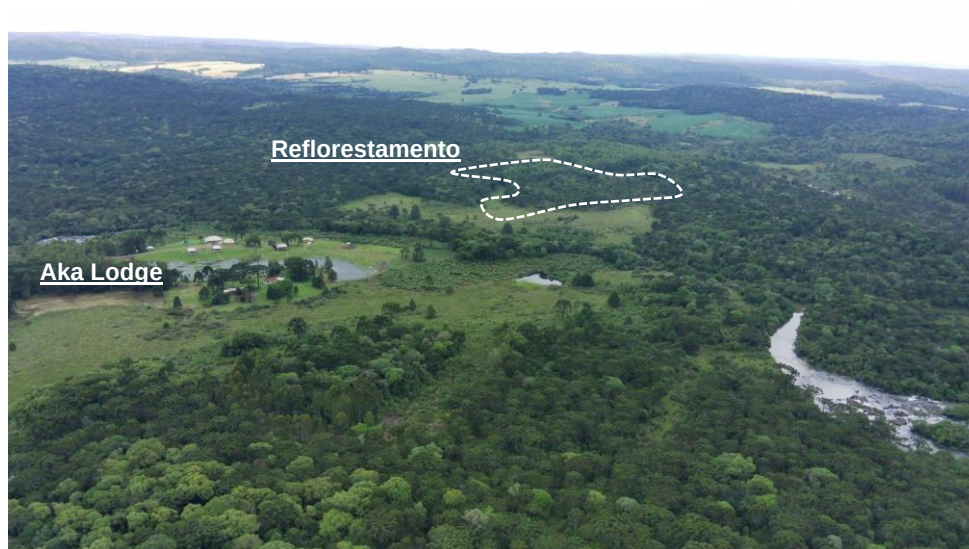
Figura 23: Áreas de reflorestamento, ao fundo, previsto como bota-fora do canal adutor auxiliar e Aka Lodge, empreendimento referência de turismo rural na região.
