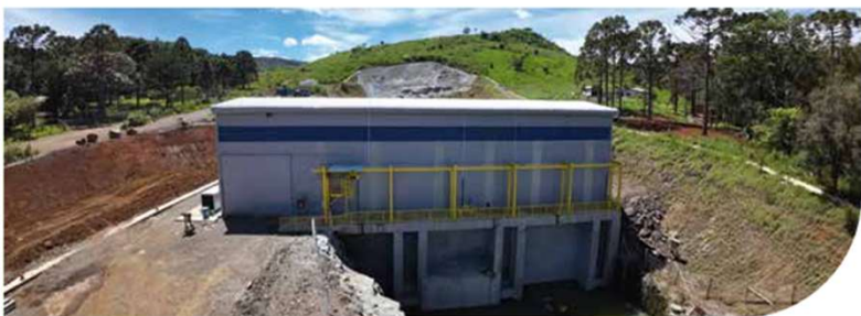
Obras da PCH São Jerônimo Bauarbeiten des Kleinwasserkraftwerks São Jerônimo Works at the São Jerônimo Small Hydroelectric Power Plant
